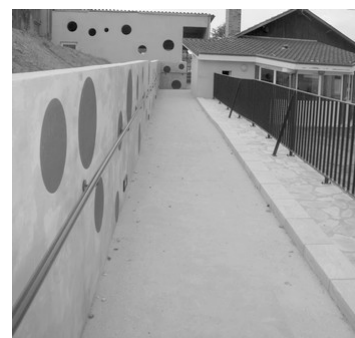
La rampe d'accès et la salle d'activité accueilleront les élèves dès la prochaine rentrée scolaire.
