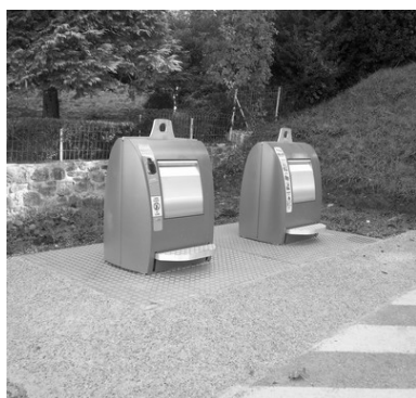
Les containers enterrés sur le parking du château
